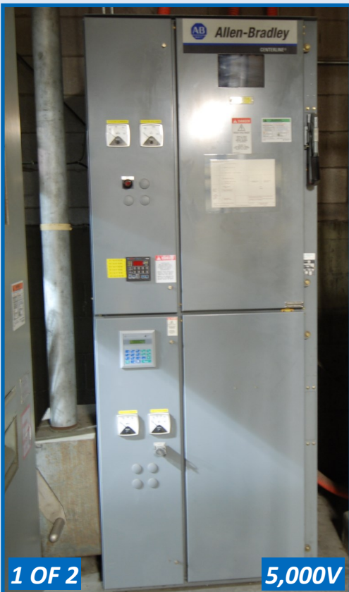
ALLEN BRADLEY SWITCHGEAR
